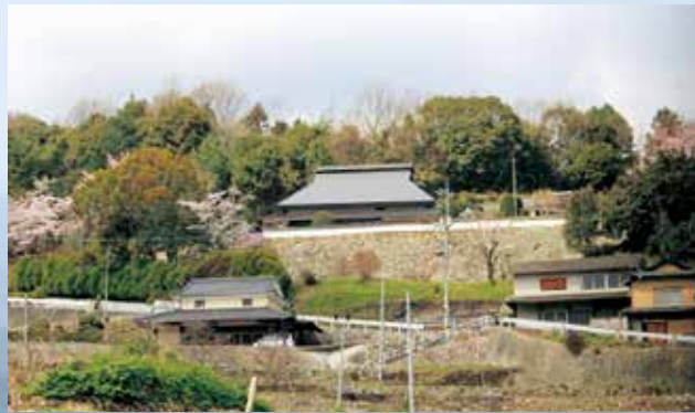
石垣の上に建つ桑田家住宅の主屋
