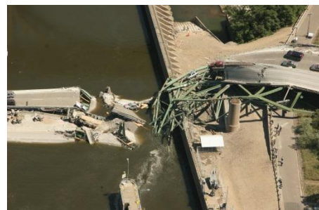
ミネアポリスで起きた橋梁崩落事故
