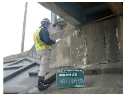
定期点検 (下部工)
