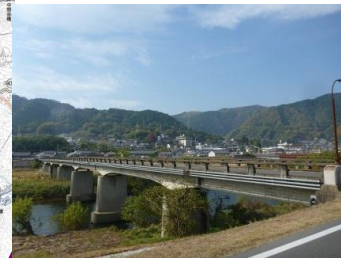
府中大橋 L=138.2m(RC橋) 1956年架設
