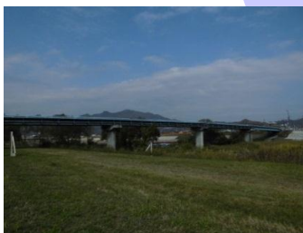
用土橋 L=131.6m(鋼橋) 1970年架設
