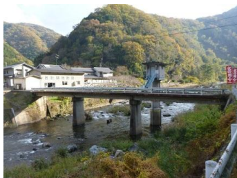
神谷橋 L=34.9m(RC橋) 1973年架設
