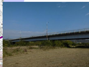
中須大橋1 L=28.7m(鋼橋) 1979年架設
