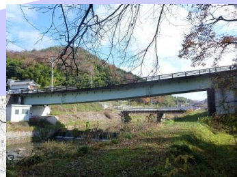
新深江大橋 L=33.3m(鋼橋) 1993年架設
