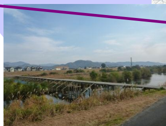
鳴谷橋1 L=132.5m(RC橋) 1955年架設
