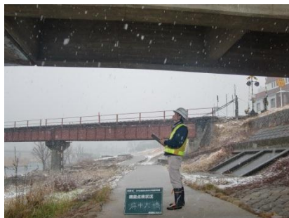
定期点検 (上部工)
