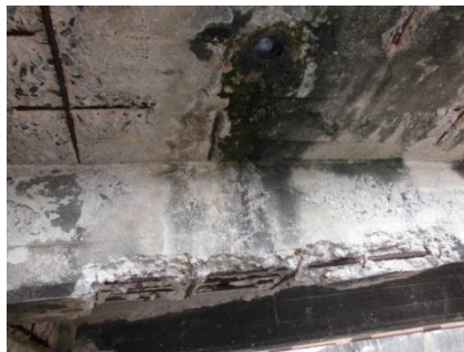
コンクリート桁の剥離・鉄筋露出
