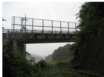
深江跨線橋 L=17.1m(PC橋) 1994年架設
