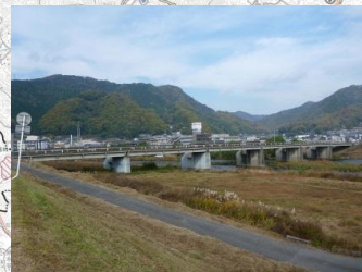
府中新橋 L=150.5m(PC橋) 1960年架設
