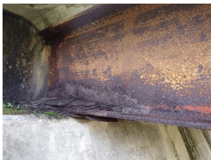
鋼桁の腐食
