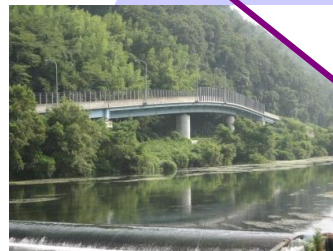
備後嵐山跨線橋 L=182.0m(鋼橋) 1990年架設
