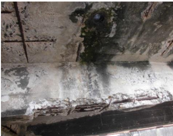
鋼桁の腐食
