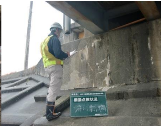
定期点検 (下部工)
