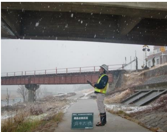
定期点検 (上部工)
