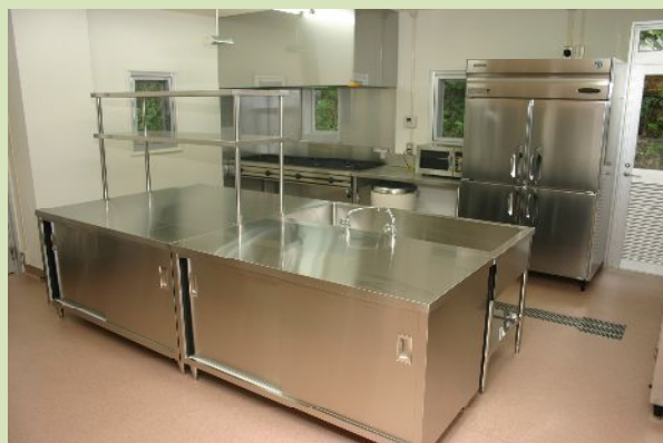
食事のご提供はこちらの調理室から
