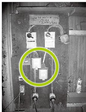
昭和50年以前に製造されたコンデンサは保安装置が内蔵されていません。そうしたコンデンサは、経年劣化により出火する危険があり、特に気温が高い6月から9月に多く発生する傾向にあります。建物に設置されている配電盤などのコンデンサを確認し、コンデンサの使用の停止・交換を行うってください。
