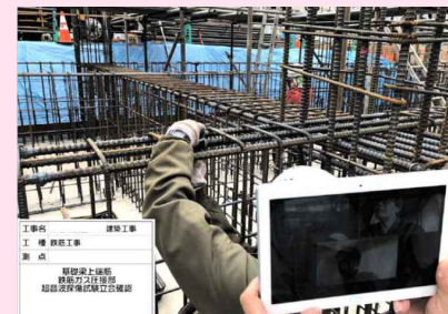
Webカメラを利用した遠隔検査
