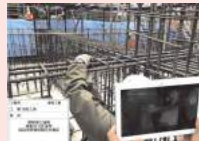
Webカメラを利用した遠隔検査
