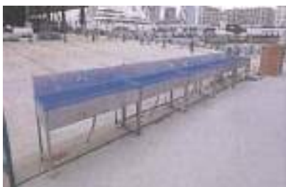
現場の手洗い場所の増設
