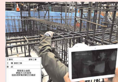
Webカメラを利用した遠隔検査
