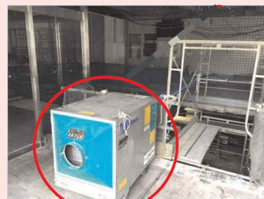
集塵機を設置し室内の換気を実施
