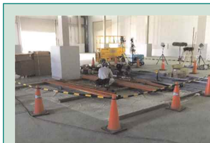
工事エリアの区画を設定して作業
