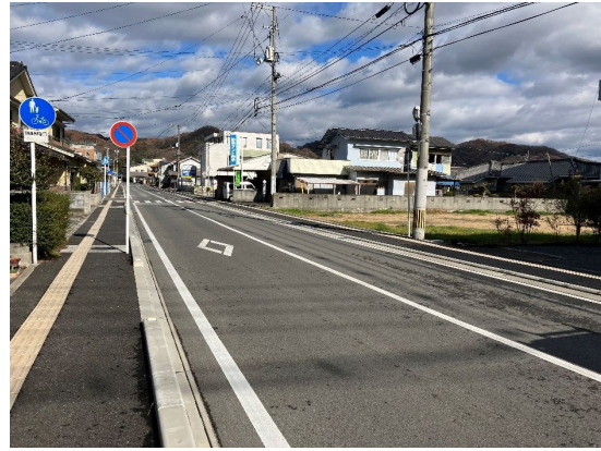
▲道路／(市)土生元町線整備事業
