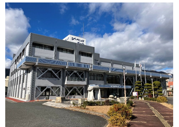
▲地域生活基盤施設／ 文化センター耐震改修事業
