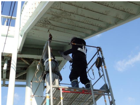
定期点検 (上部工)
