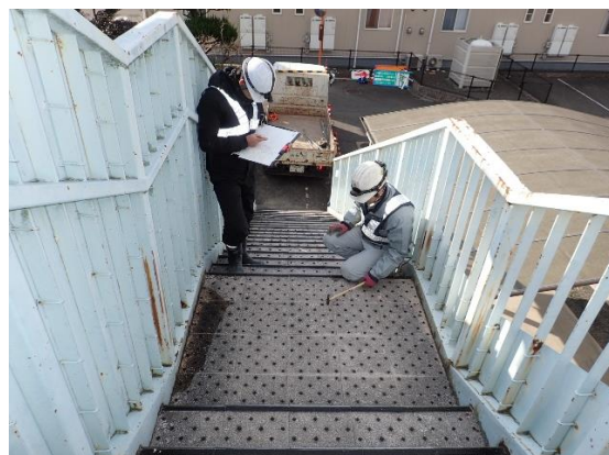
定期点検 (階段工)
