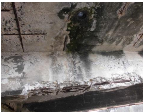
鋼桁の腐食
