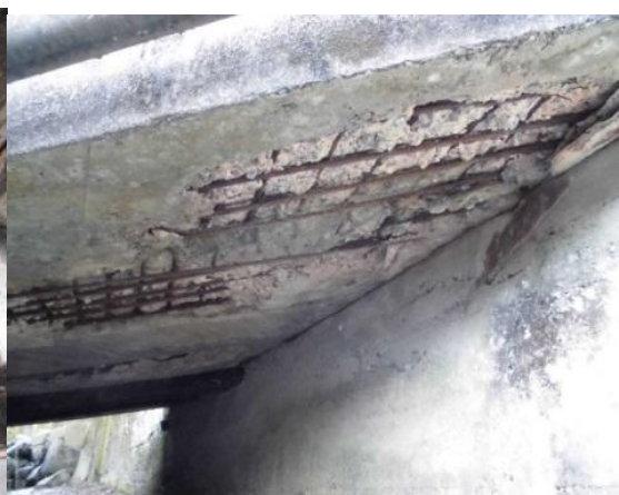
コンクリート桁の剥離・鉄筋露出
