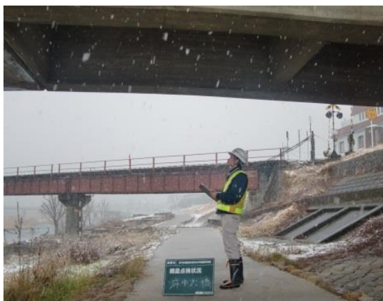
定期点検 (上部工)
