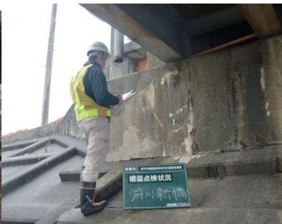
定期点検 (下部工)
