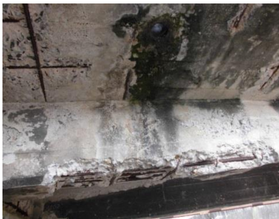
鋼桁の腐食
