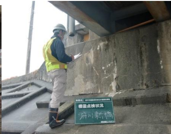
定期点検 (下部工)
