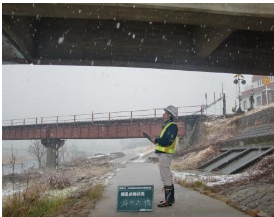
定期点検 (上部工)
