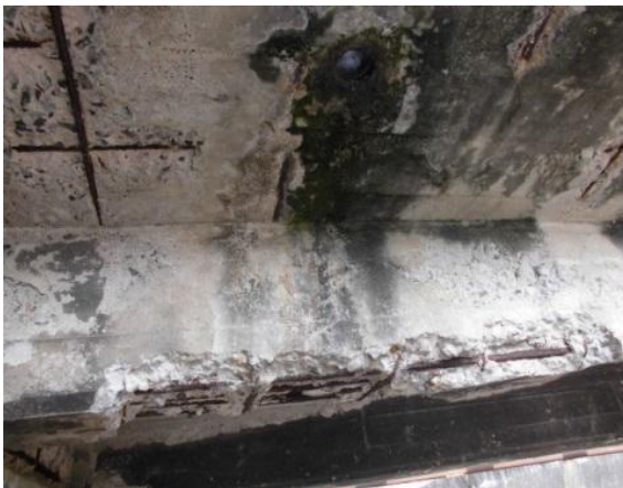
鋼桁の腐食
