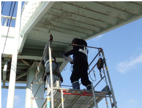
定期点検 (上部工)
