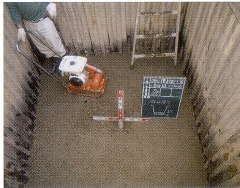
基礎砕石敷設転厚圧工事状況
