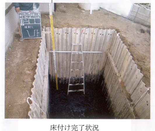
床付け完了状況
