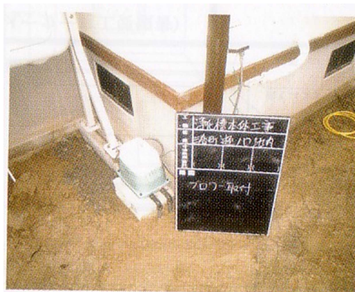
フロア設置工事
