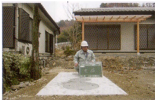
浄化槽工事竣工状況
