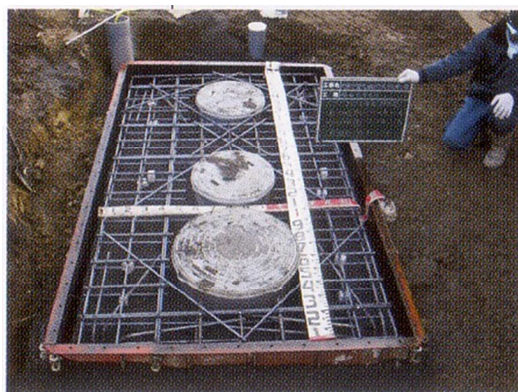
上部スラブ配筋状況
