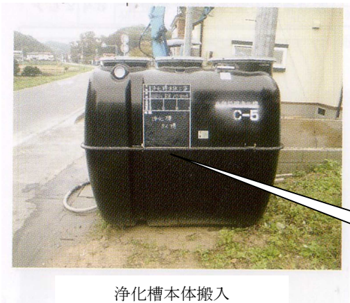
浄化槽本体搬入
