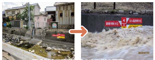
平成30年7月豪雨時の出口川の様子
