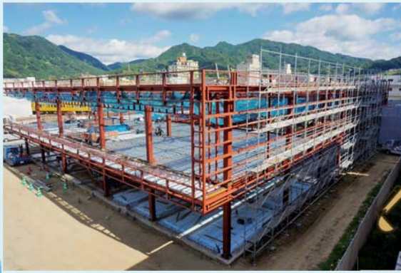
SPINGLE ウェルネスセンター工事中
