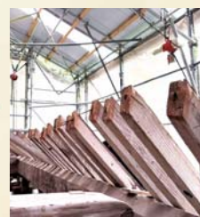
地垂木の彩色 隠れていた部分は風化せず色が残っています
