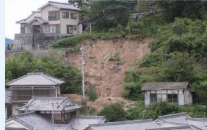
▲がけ崩れ(平成22年7月:豪雨災害)
