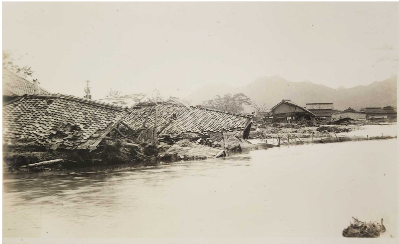
枕崎台風の被害 国府村・高木の被害（1945年）
