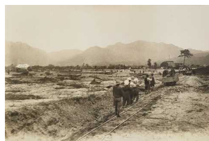
枕崎台風復旧工事
