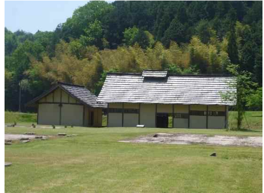
遺構の上に建物を整備した例：台所と付属屋の復元（史跡吉川氏城館跡 吉川元春館跡：北広島町）
