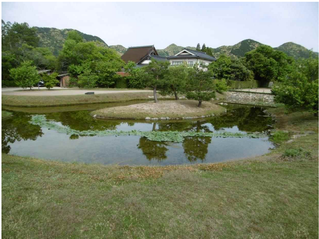
かさ上げ復元の事例 遺構を保護（盛土）し、その上部に池泉庭園を復元（史跡大内氏遺跡 館跡：山口市）
