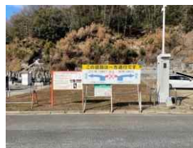
金龍寺東地区 ポンプアップ施設 及び交通誘導板
