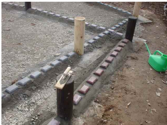
施工中の掘立柱・界線（史跡吉川氏城館跡 小倉山城跡：北広島町）
