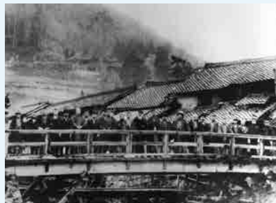
明治38年翁橋 〔架換渡橋式〕
