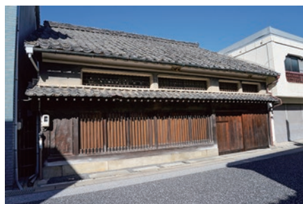
旧田辺邸 2階の高さを低く抑えた造りが特徴で す。2階には、通気や明り取り用の鉄格子が はめ込まれた横長長方形の窓があります。
