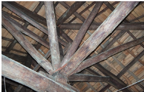
天井を支える柱の骨組み
