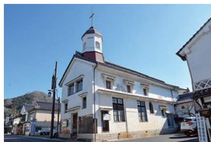
上下教会 旧角倉家の蔵で、屋根の上の八角形の 塔屋が目をはく建物です。戦後に改修し、 キリスト教会として利用されています。
