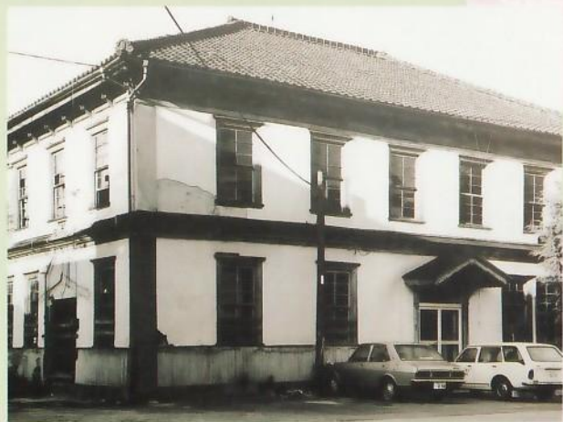
移築直前の建物の様子
