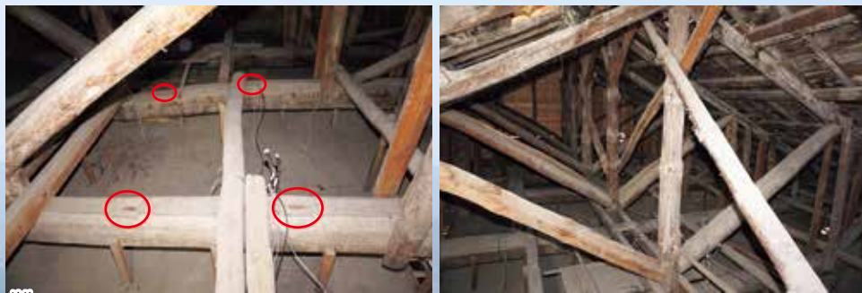
梁材に残る未使用の束用枘穴（赤丸囲み） 三角形構成が特徴のキングポストトラス
