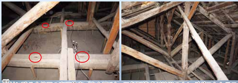
梁材に残る未使用の束用枿穴（赤丸囲み） 三角形構成が特徴のキングポストトラス
