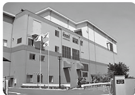
府中市クリーンセンター
