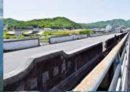
コンクリート製欄干のデザインが特徴的な現扇橋(手前)と工事が進む新扇橋(左奥)
