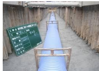
下水道管設置イメージ
