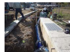
配水管布設状況
