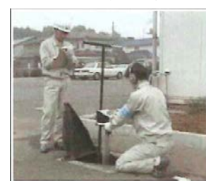
管路診断調査の状況
