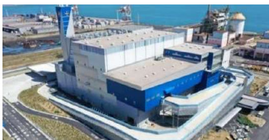
福山ローズエネルギーセンター (ふくやま環境美化センター)
