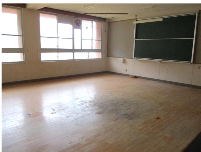
【3階雨漏り修繕箇所】(床)
