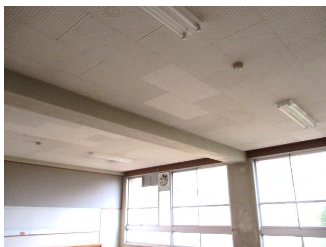
【3階雨漏り修繕箇所】(天井)
